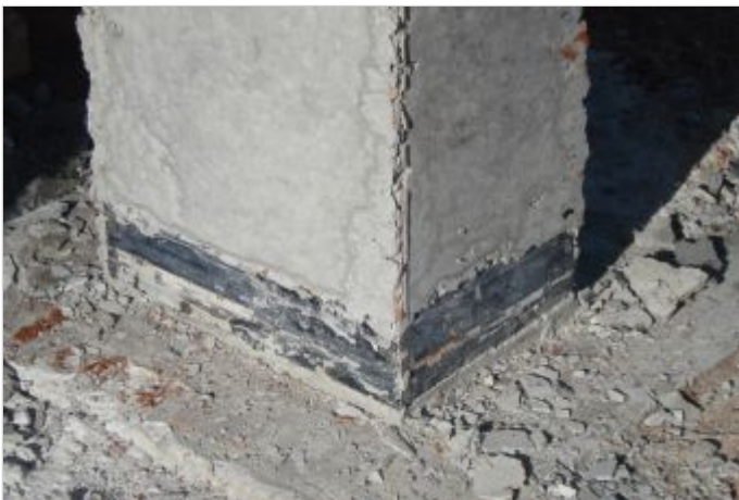
Durante la Obra
