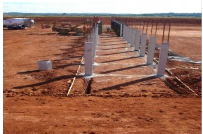
Durante la Obra
