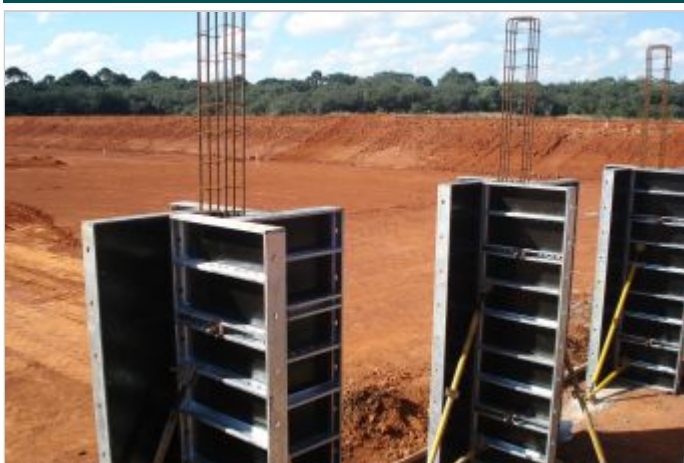
Durante la Obra
