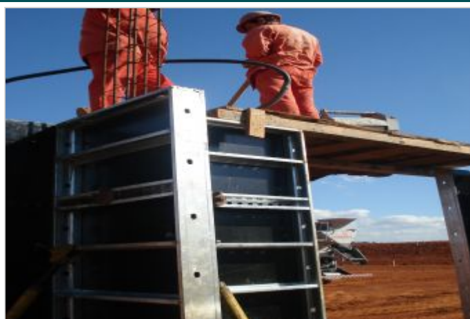
Durante la Obra
