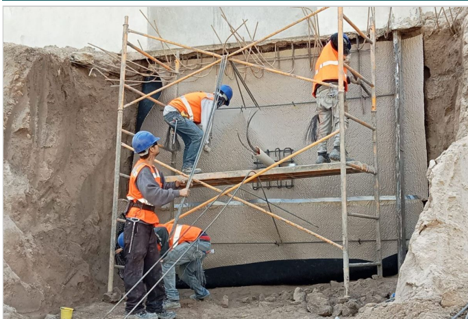
Durante la Obra
