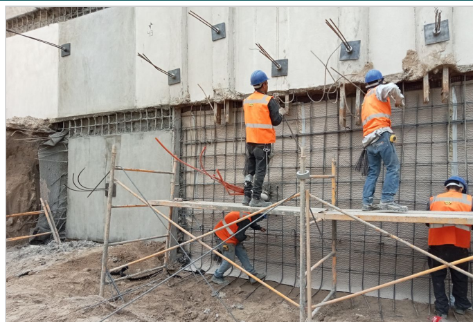
Durante la Obra
