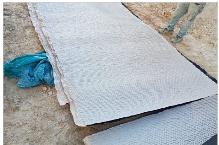
Durante la Obra
