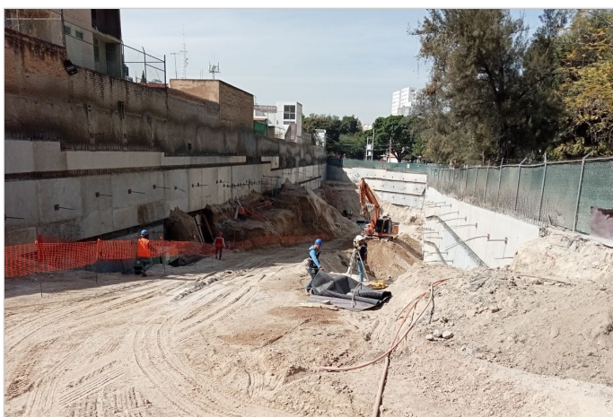
Durante la Obra
