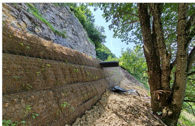
Secteur 6 et vue de la buse d'évacuation d'eau
