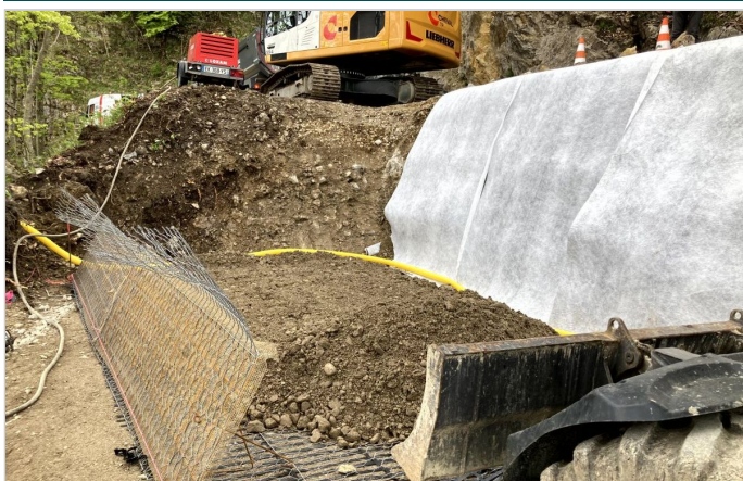
Secteur 6 - mise en place du remblai
