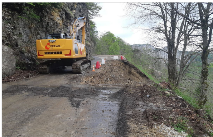
Avant le début des travaux
