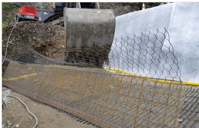
Mise en place du module et remplissage avec du remblai
