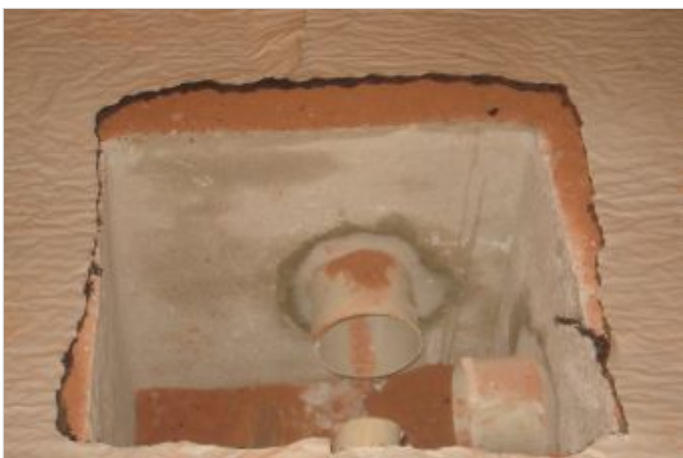
Durante a obra
