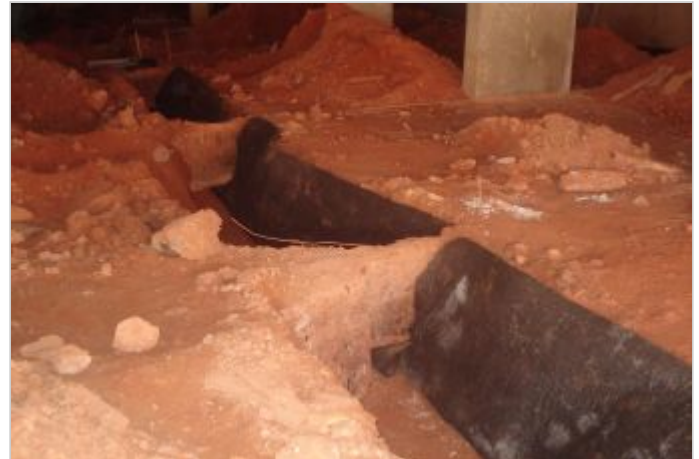
Durante a obra
