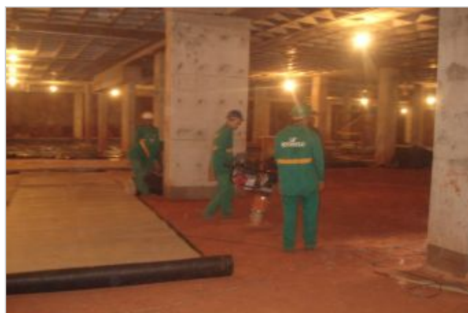
Durante a obra
