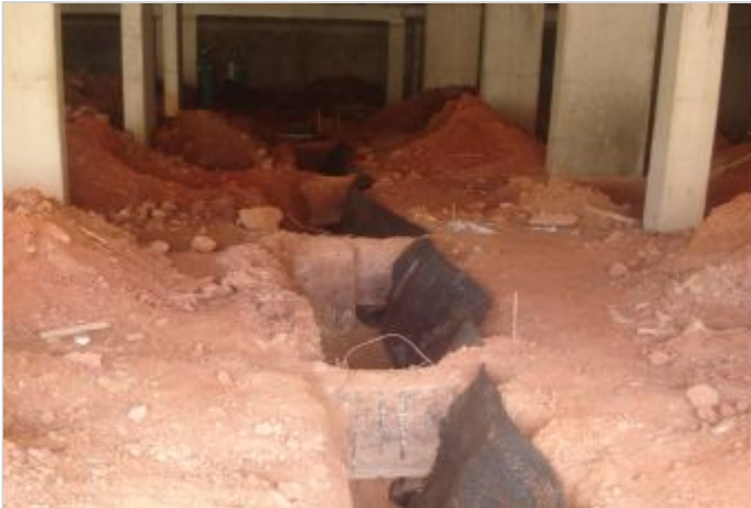
Durante a obra
