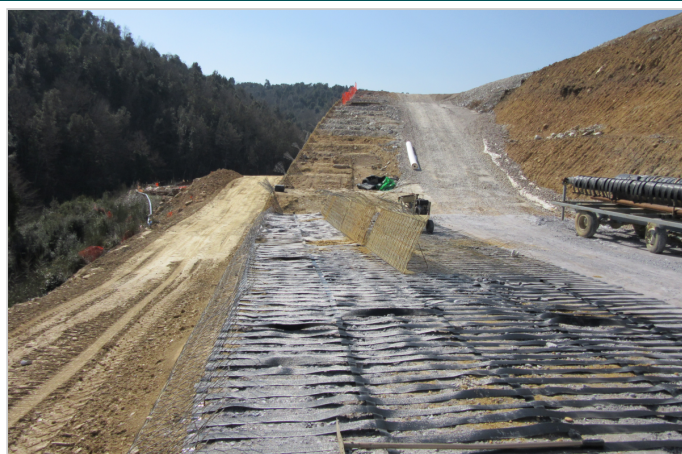
Fasi di montaggio Terramesh e geogriglie Paralink
