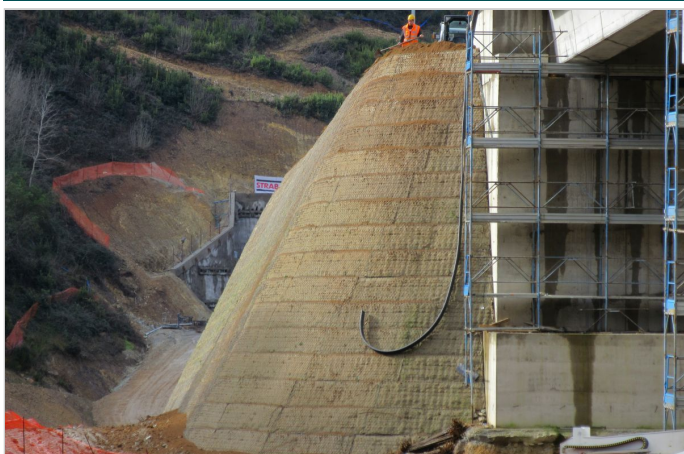
Chiusura del muro in Terramesh Verde contro la spalla di viadotto
