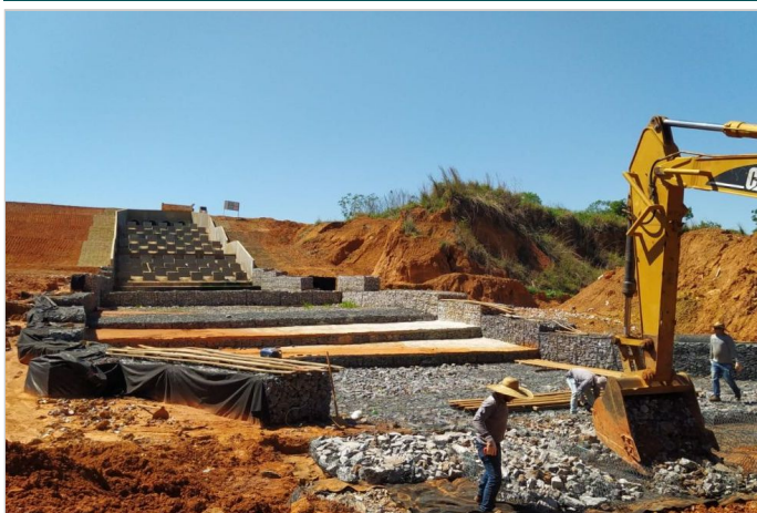
Durante a obra
