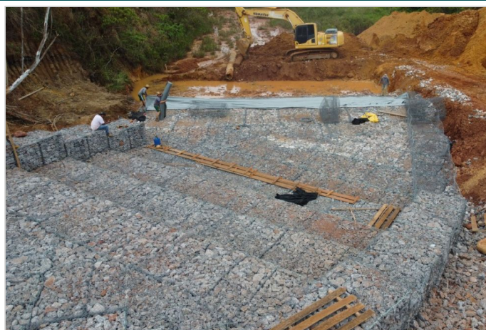
Durante a obra
