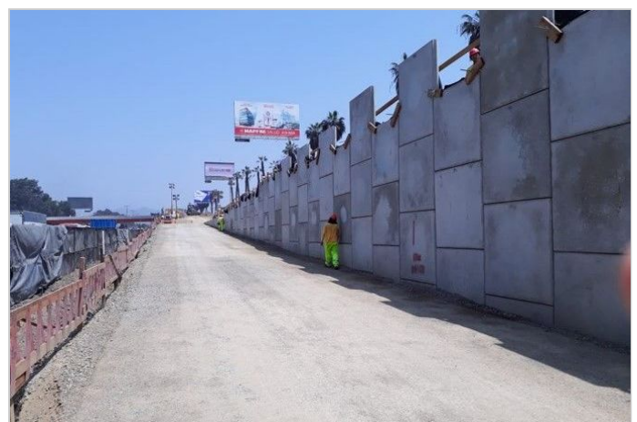
Durante la Obra
