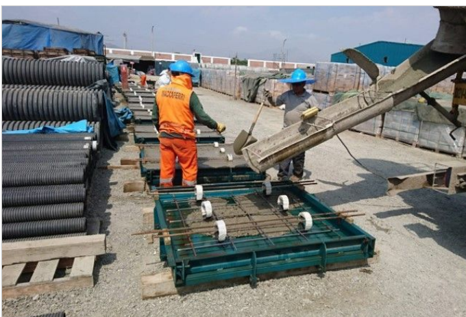
Durante la Obra
