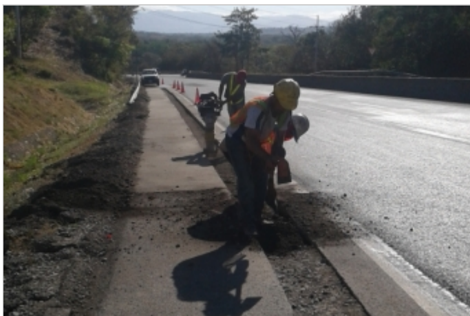
Durante la Obra
