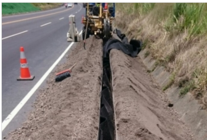
Durante la Obra
