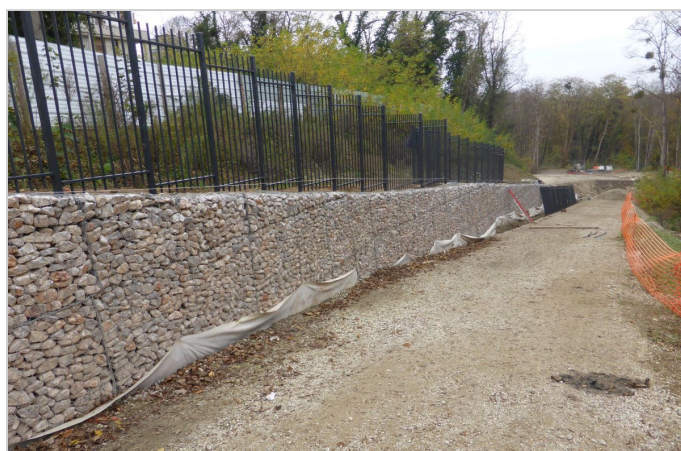
Mur sud gabions DT
