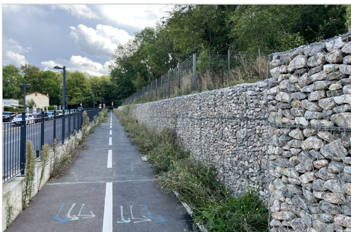
Mur poids en gabions - 2022
