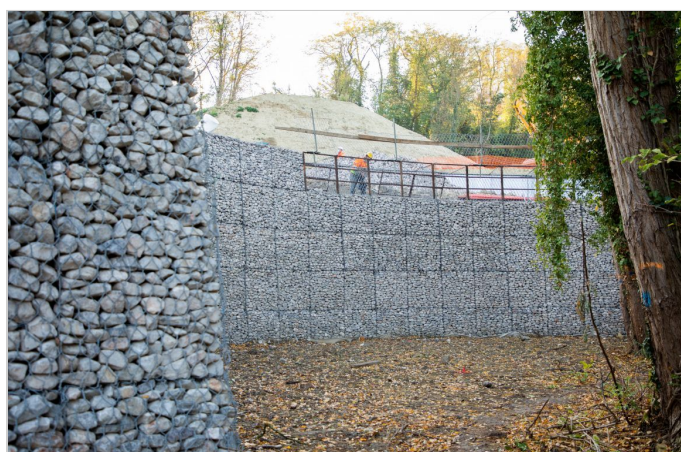
Mur Belvédère en Terramesh System
