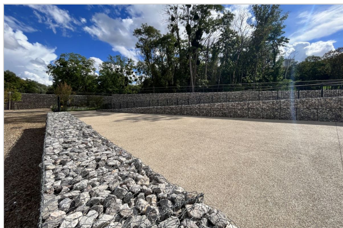
Mur poids en gabions - 2022
