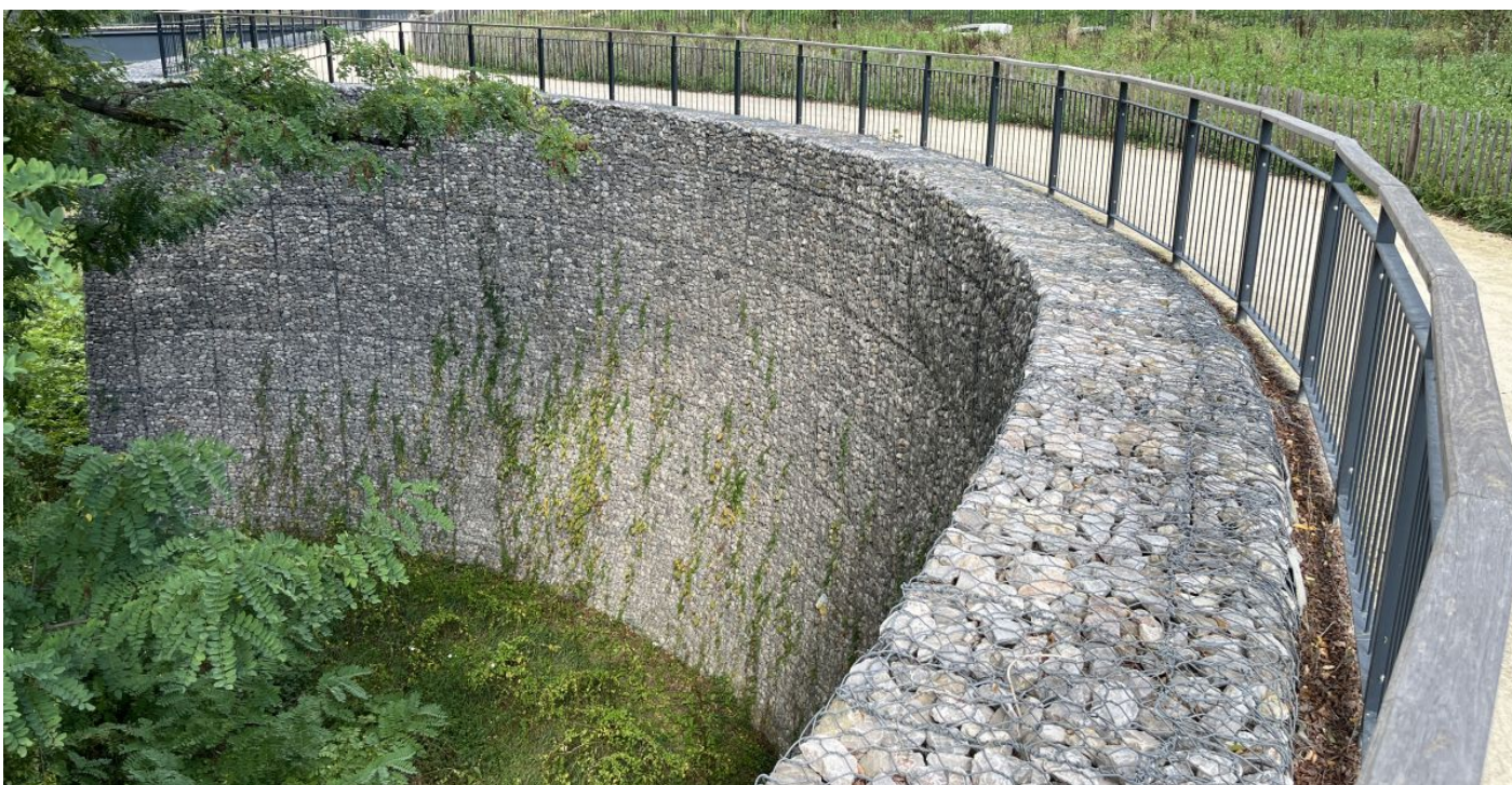
Mur en Terramesh System - 2022
