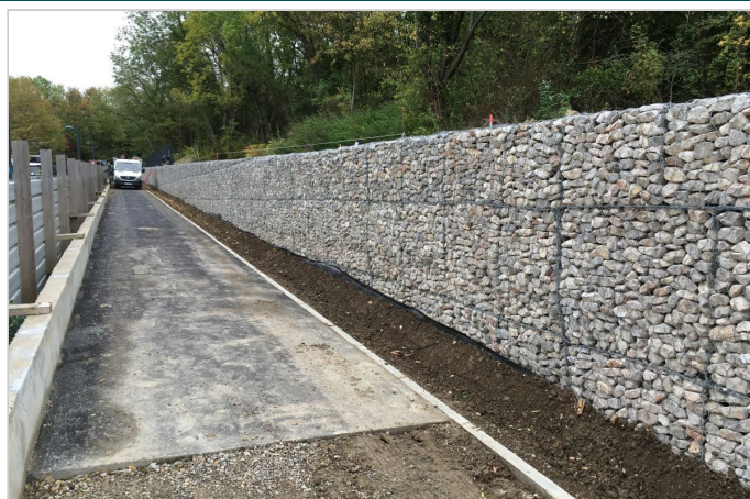
Mur nord en gabions DT
