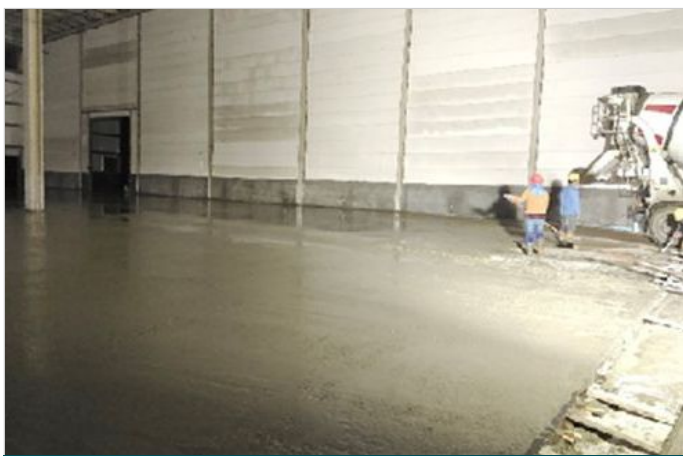
图5 钢纤维混凝土现场浇筑
