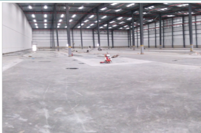
钢纤维混凝土地坪
