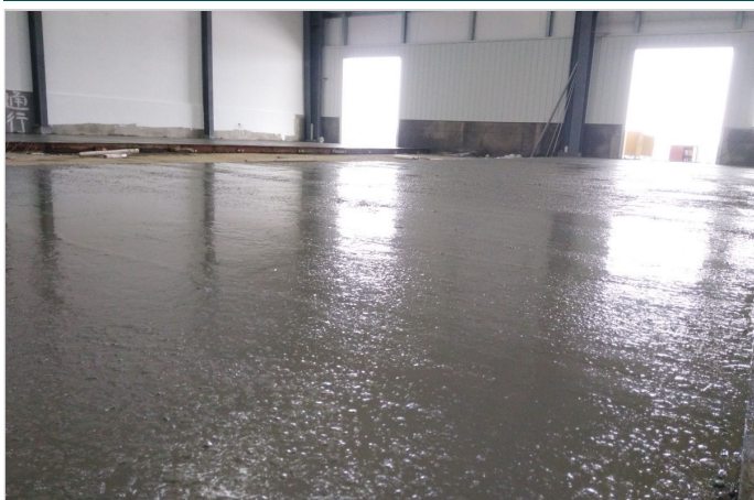
钢纤维混凝土浇筑
