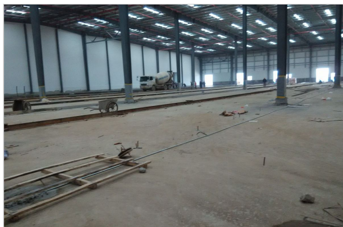
地坪素混凝土垫层
