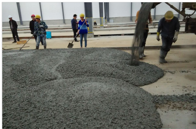
地坪素混凝土垫层
