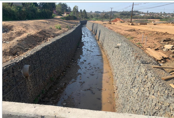
Durante a obra
