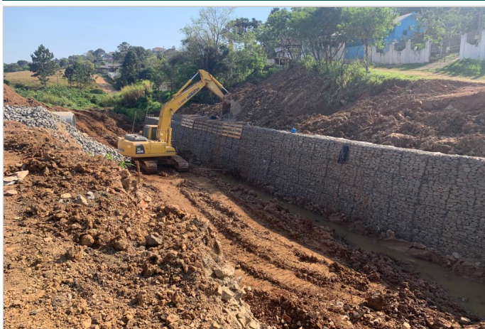
Durante a obra
