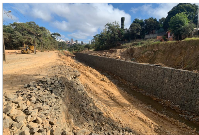
Durante a obra
