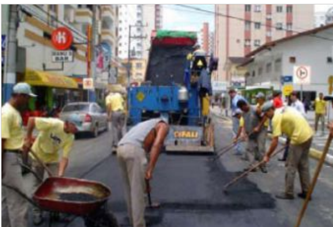
Durante a obra
