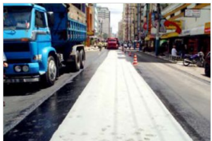
Durante a obra
