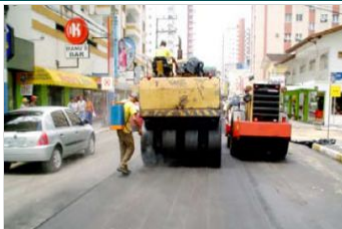
Durante a obra
