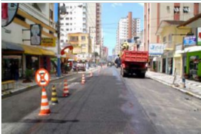
Durante a obra
