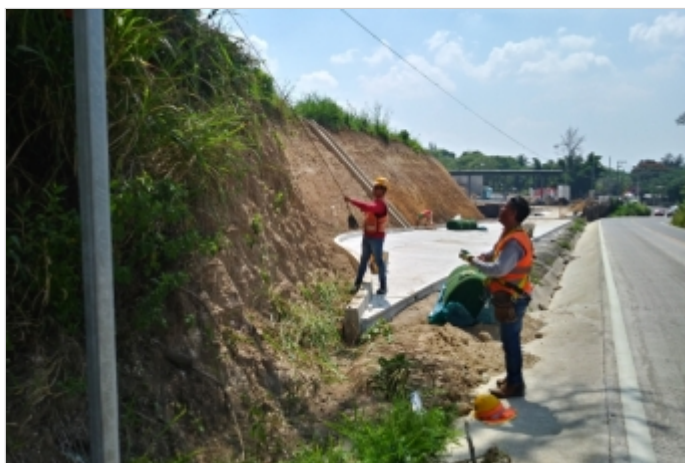
Durante la Obra
