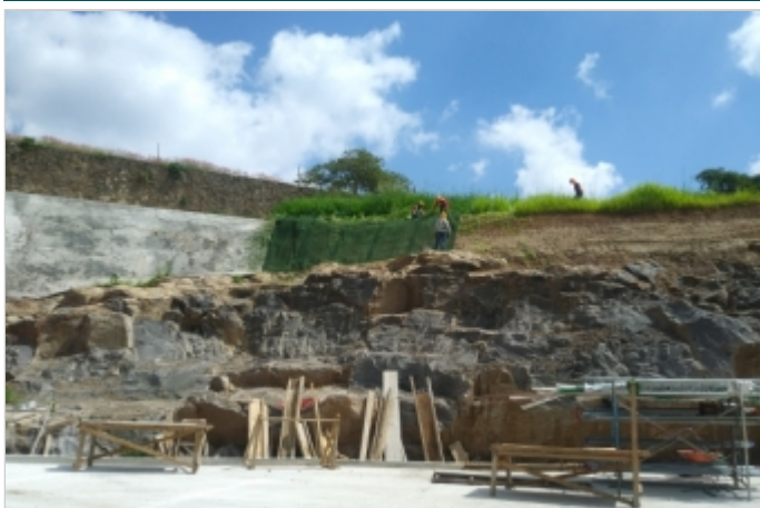
Durante la Obra
