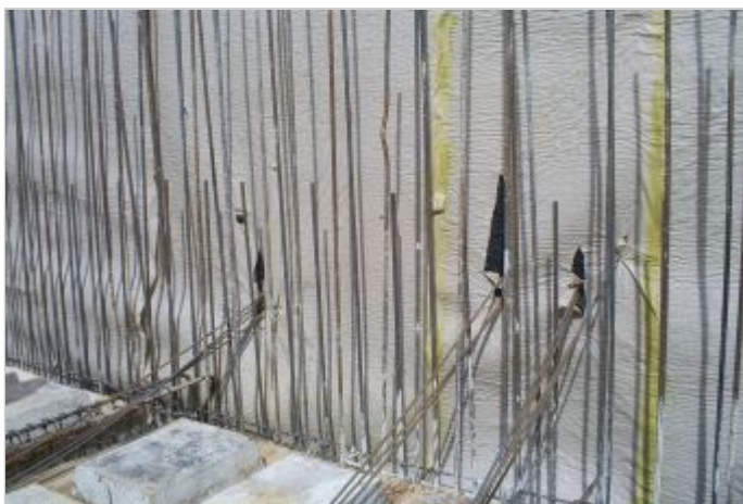
Durante la Obra
