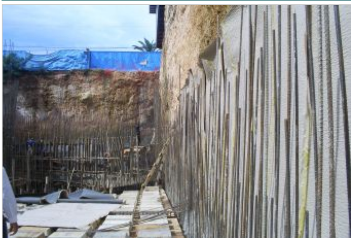
Durante la Obra
