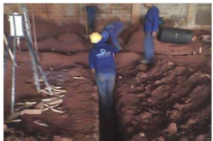
Durante a obra
