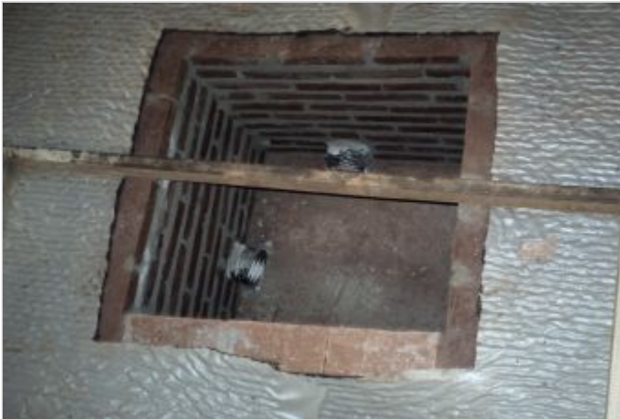
Durante a obra
