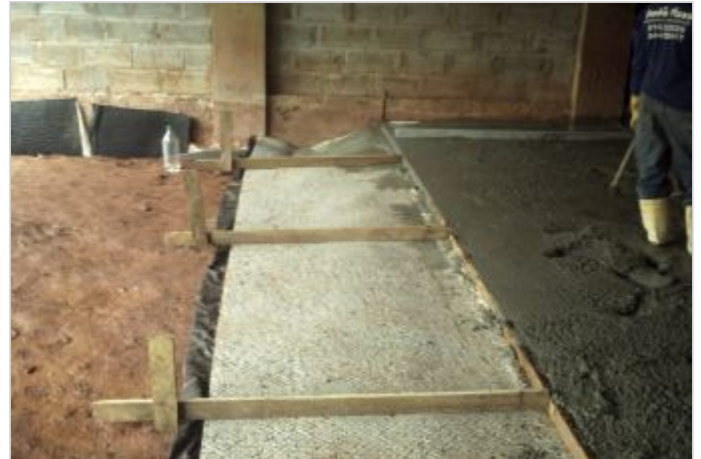
Durante a obra
