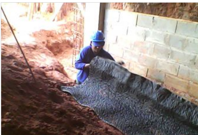
Durante a obra
