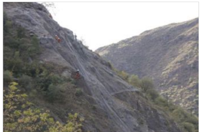
Durante a obra
