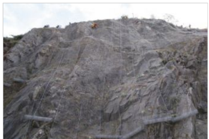
Durante a obra
