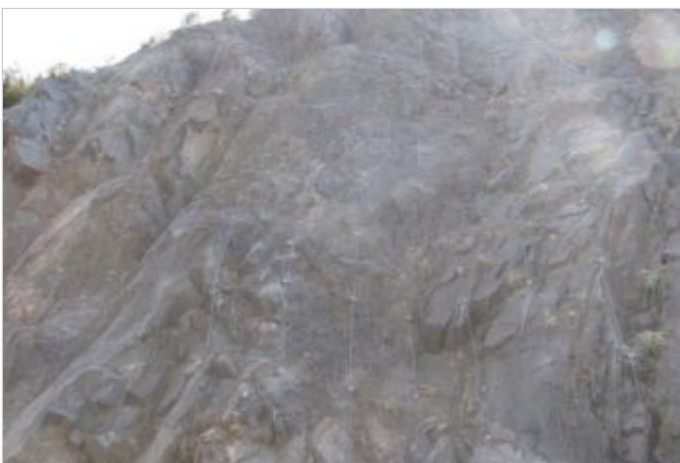
Durante a obra
