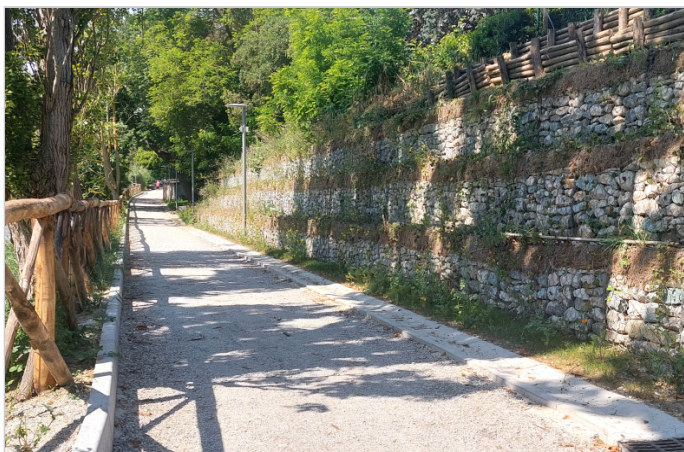
L'opera in gabbioni verdi
