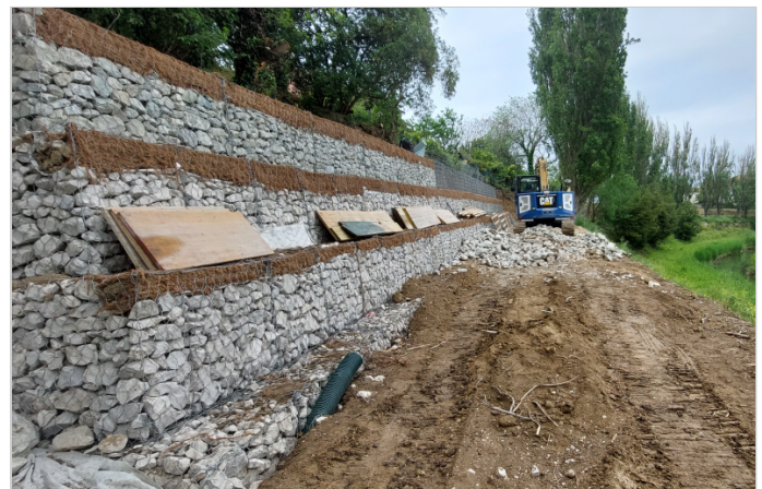
Fase costruttiva dell'opera in gabbioni verdi
