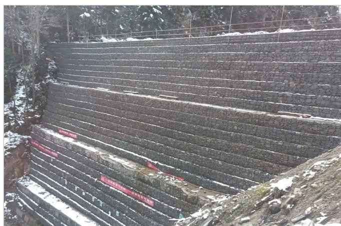
施工完成照片
