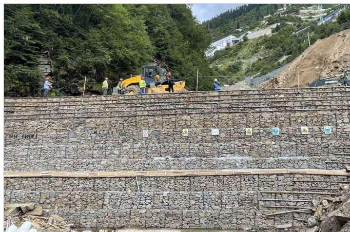
施工中照片：施工细节处理
