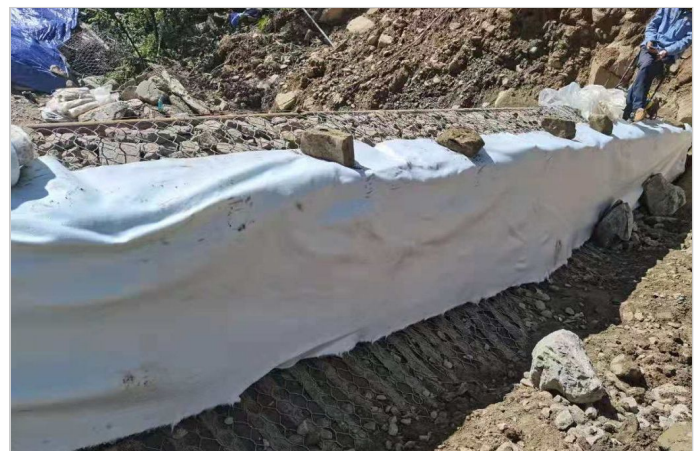
施工中照片：面墙后铺设聚酯长纤无纺布反滤
