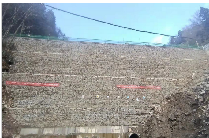
施工完成照片
