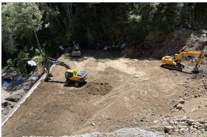
施工中照片：结构填土回填压实
