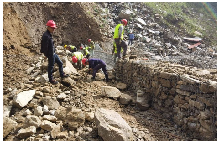
施工中照片：石料装填
