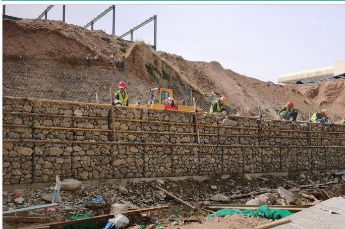
加筋格宾施工
