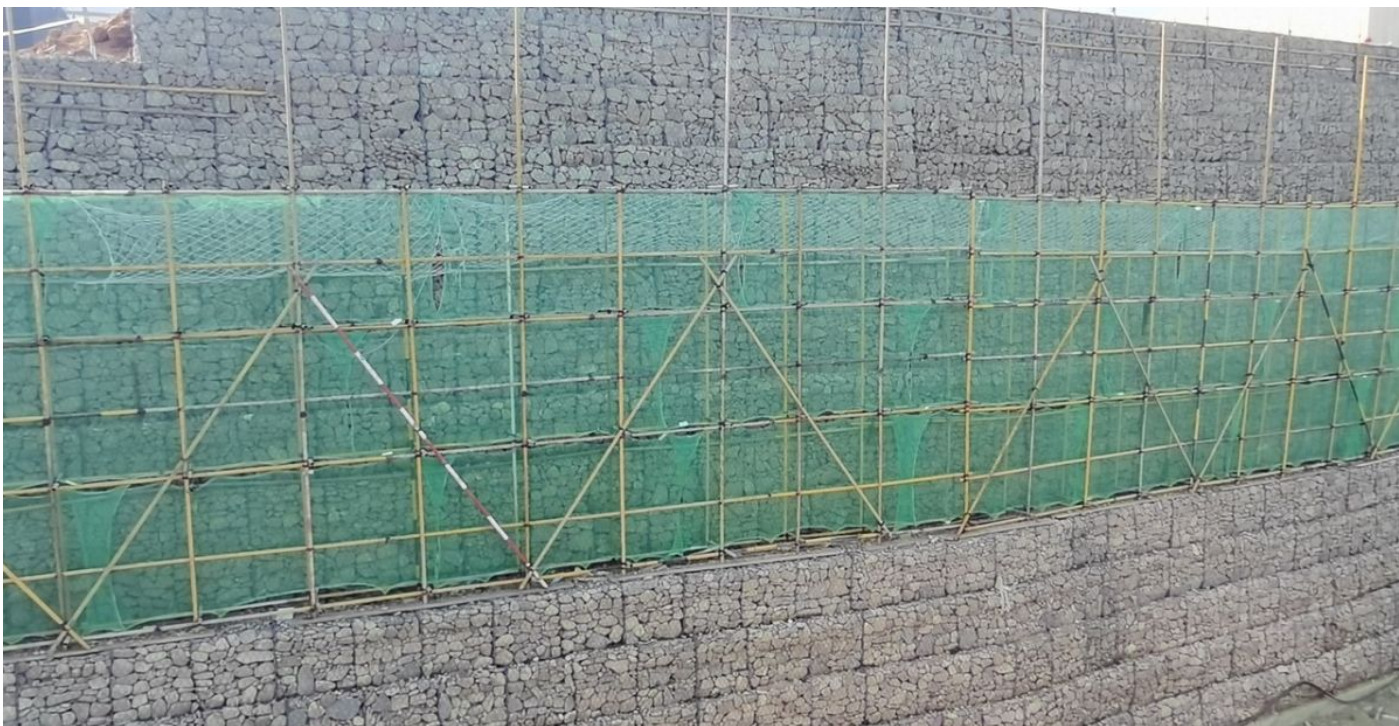
加筋格宾施工
