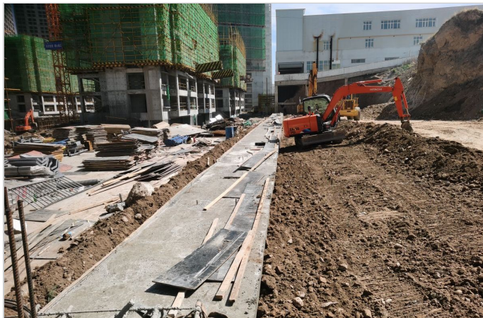
挡墙基础施工
