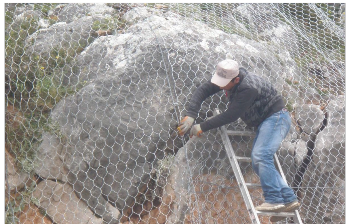
ΕΡΓΑΣΙΕΣ ΤΟΠΟΘΕΤΗΣΗΣ ΠΛΕΓΜΑΤΟΣ ΠΡΟΣΤΑΣΙΑΣ ΠΡΑΝΩΝ STEELGRID MO-150
