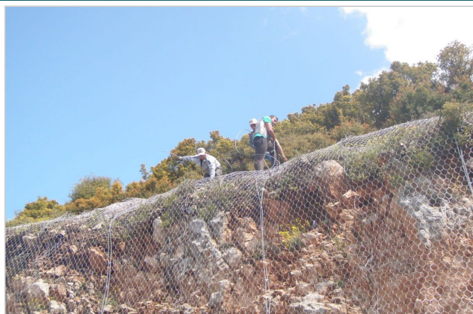
ΕΡΓΑΣΙΕΣ ΤΟΠΟΘΕΤΗΣΗΣ ΠΛΕΓΜΑΤΟΣ STEELGRID MO-150 ΣΤΗΝ ΣΤΕΨΗ ΤΟΥ ΠΡΑΝΟΥΣ
