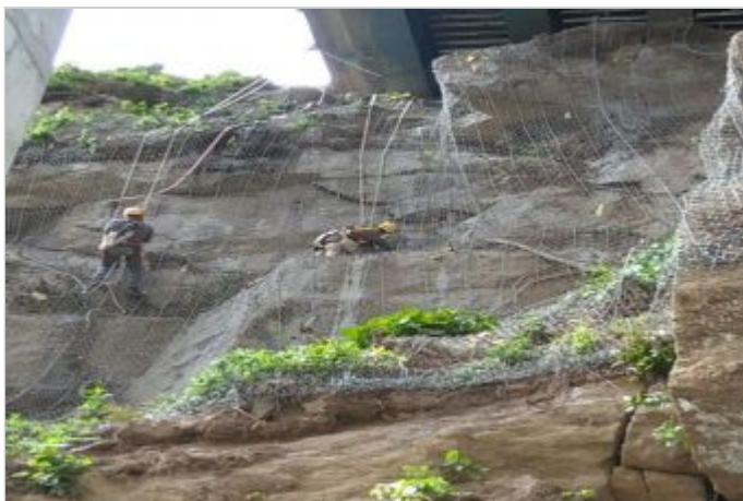
Durante la Obra
