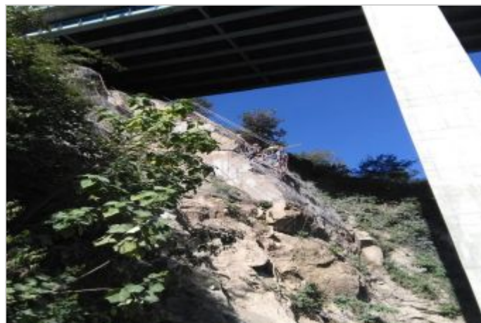
Durante la Obra
