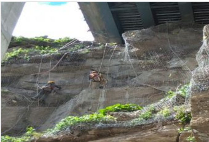
Durante la Obra
