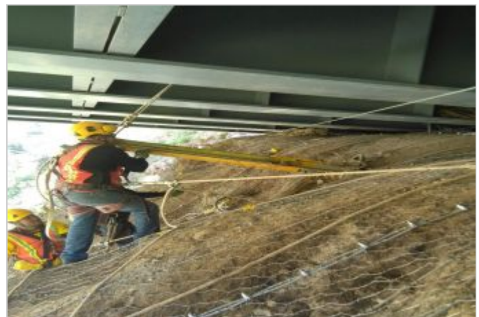
Durante la Obra
