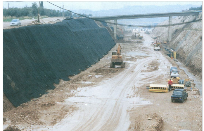
ΤΡΙΣΔΙΑΣΤΑΤΟ ΓΕΩΠΛΕΓΜΑ ΕΠΕΝΔΥΣΗΣ ΠΡΑΝΩΝ MACMAT R1 055 ΣΤΗ ΦΑΣΗ ΤΗΣ ΚΑΤΑΣΚΕΥΗΣ
