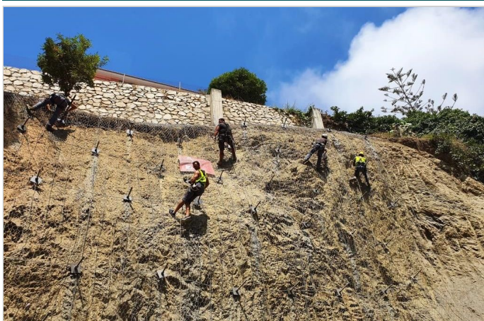
Instalación malla Steelgrid HR30
