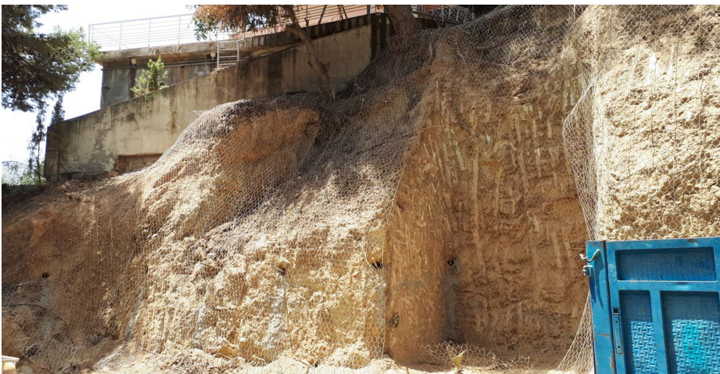
Vista general de la obra
