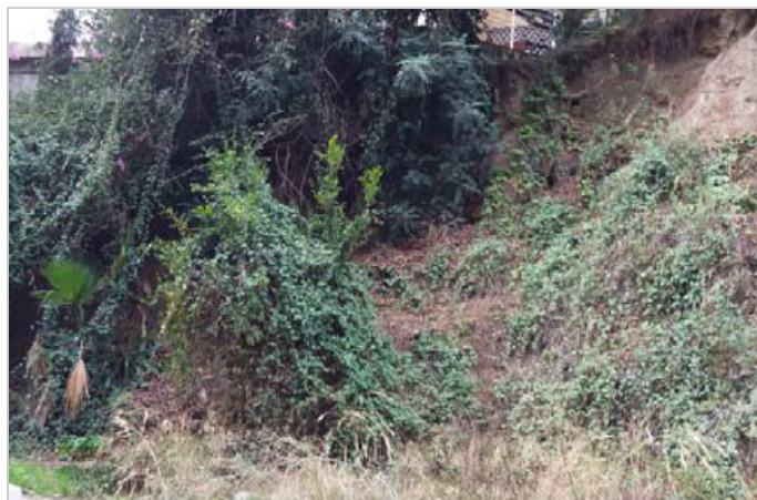
Vista general de la zona a estabilizar
