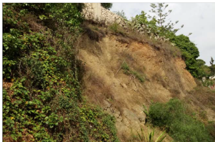
Vista general de la zona a estabilizar
