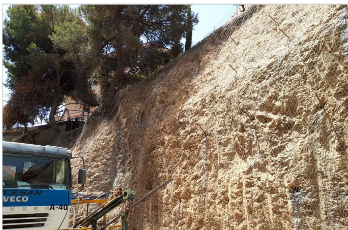
Colocación bulones GEWI d=32 mm
