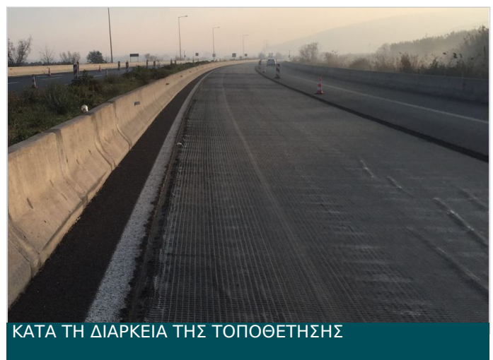
ΚΑΤΑ ΤΗ ΔΙΑΡΚΕΙΑ ΤΗΣ ΤΟΠΟΘΕΤΗΣΗΣ
