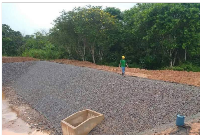
Durante a obra
