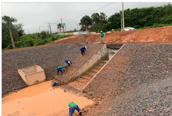
Durante a obra
