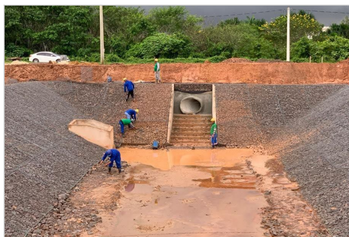
Durante a obra
