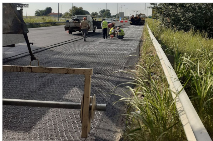
ΤΟΠΟΘΕΤΗΣΗ ΚΑΙ ΑΓΚΥΡΩΣΗ ROADMESH L
