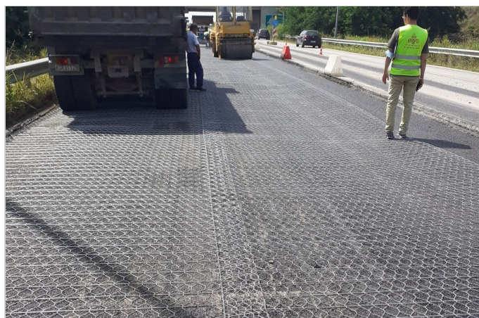
ΤΟΠΟΘΕΤΗΣΗ ΚΑΙ ΠΛΕΥΡΙΚΗ ΕΠΙΚΑΛΥΨΗ ΡΟΛΩΝ ROADMESH L
