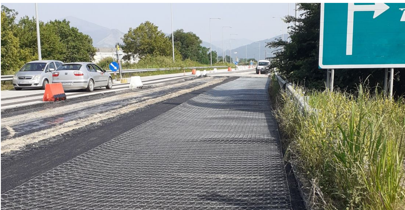
ΧΑΛΥΒΔΙΝΟ ΠΛΕΓΜΑ ΟΠΛΙΣΜΟΥ ΑΣΦΑΛΤΟΥ ROADMESH L
