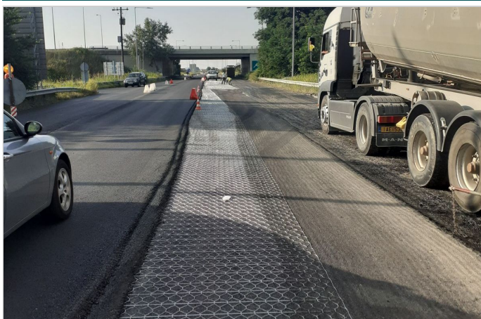
ΤΟΠΟΘΕΤΗΣΗ ΣΤΡΩΣΗΣ ΑΣΦΑΛΤΙΚΟ ΠΑΝΩ ΣΤΟ ROADMESH L
