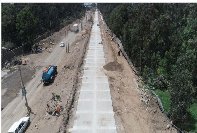
Durante la Obra
