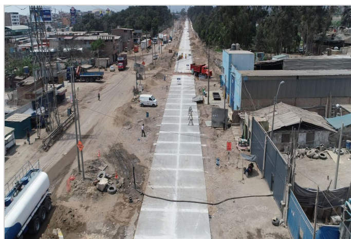
Durante la Obra
