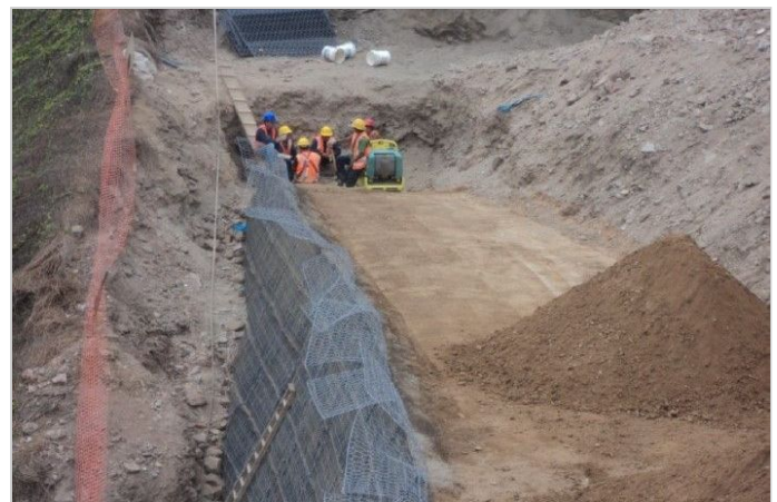
Durante la obra
