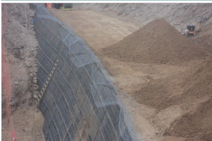
Durante la obra
