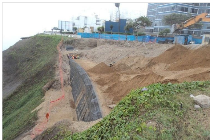
Durante la obra
