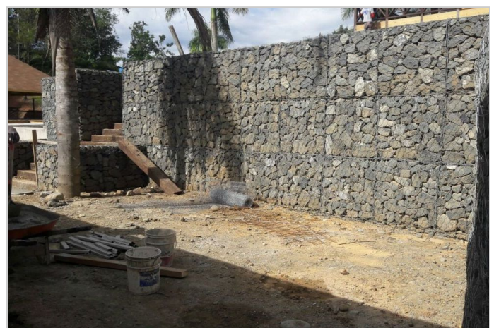
Durante la Obra
