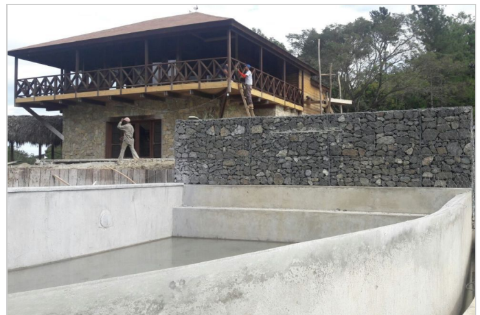
Durante la Obra
