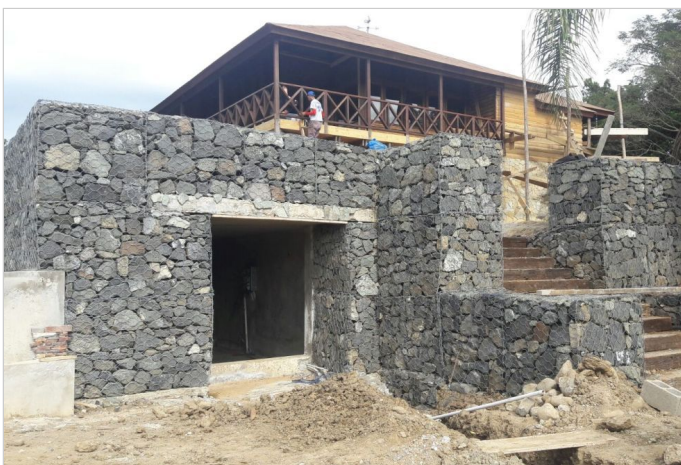
Durante la Obra
