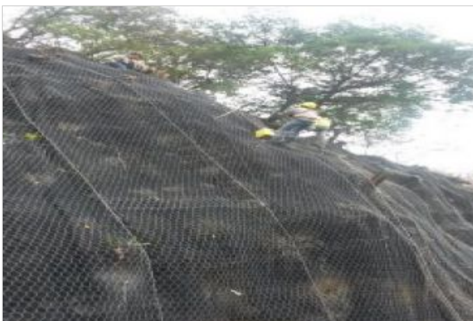
Durante la Obra
