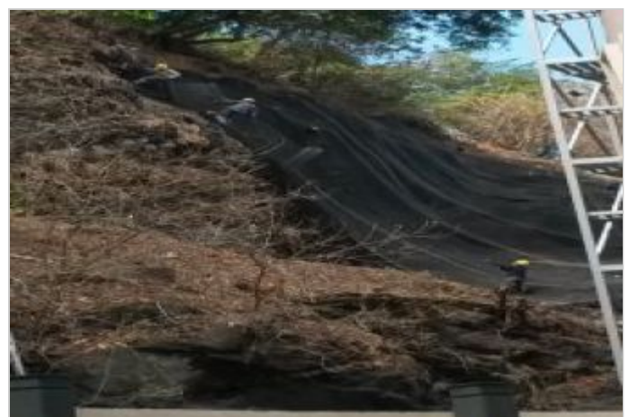
Durante la Obra
