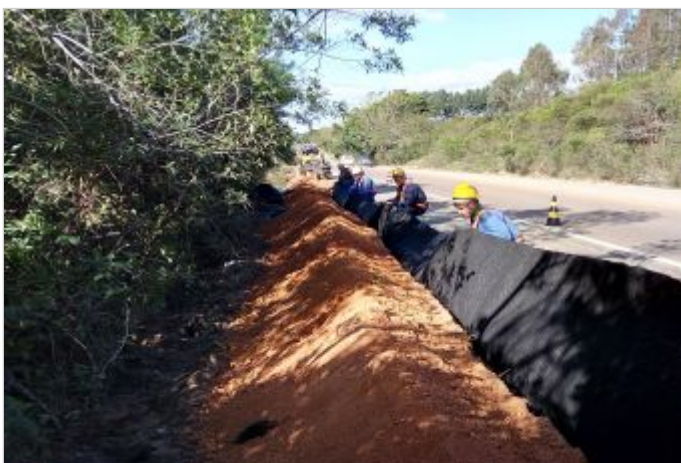
Durante la Obra
