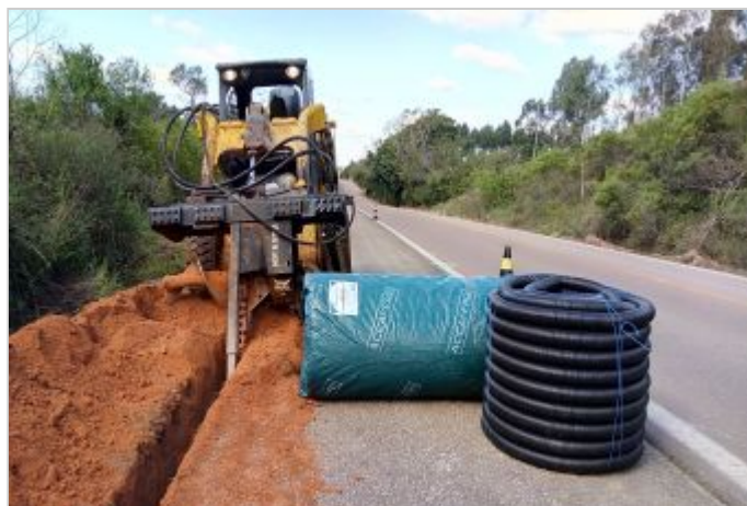
Durante la Obra
