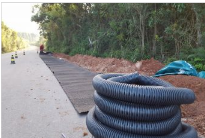
Durante la Obra
