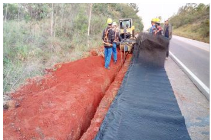
Durante la Obra
