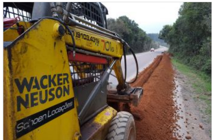
Durante la Obra
