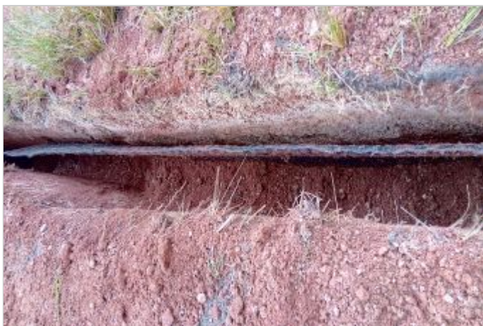
Durante la Obra
