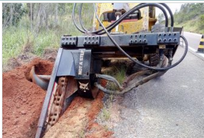
Durante la Obra
