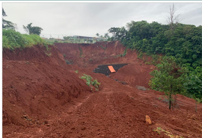
Durante a obra
