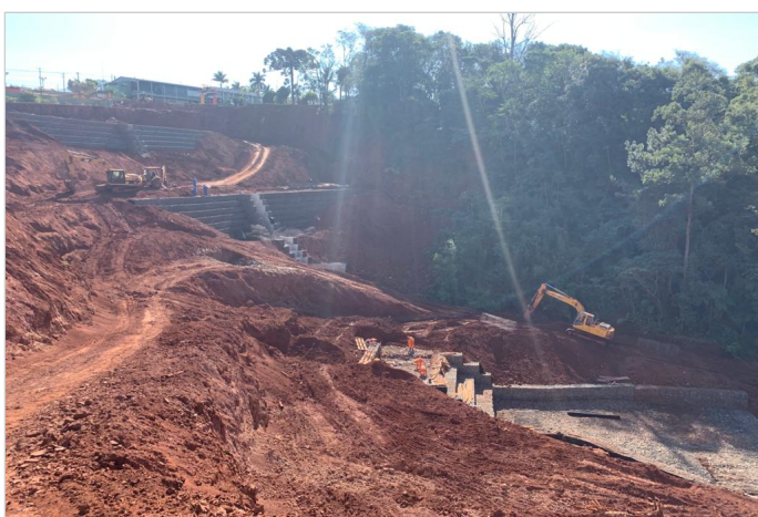
Durante a obra
