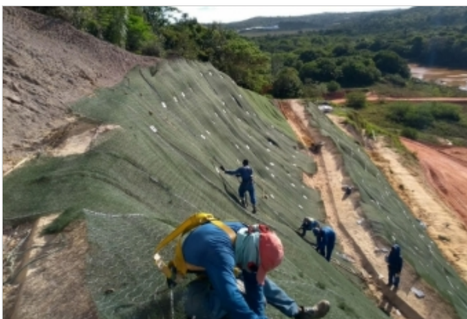
Durante la Obra
