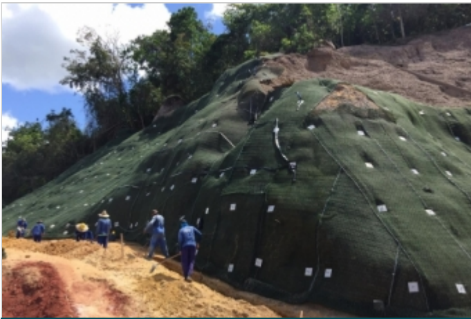
Durante la Obra
