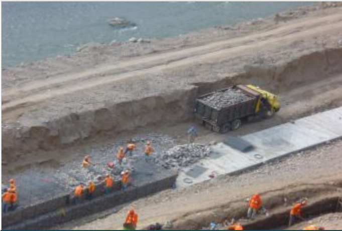
Durante a obra
