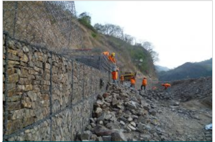
Durante a obra
