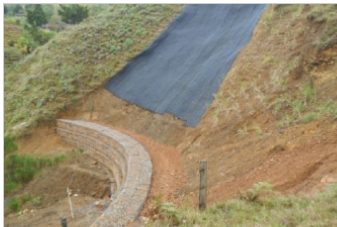
Durante a obra
