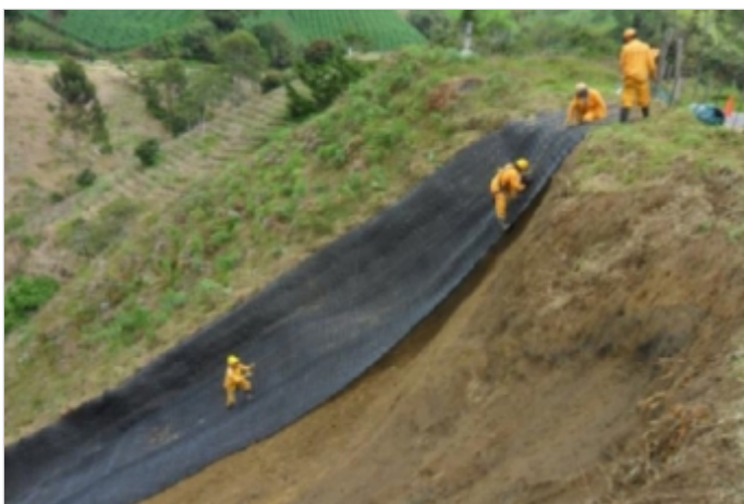
Durante a obra
