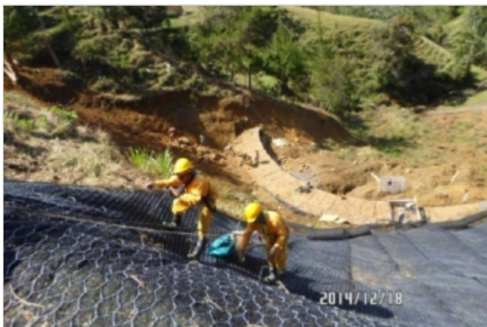
Durante a obra
