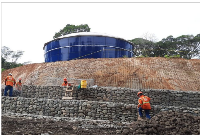
Durante la Obra
