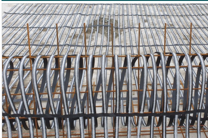
Particolare della geogriglia PARADRAIN
