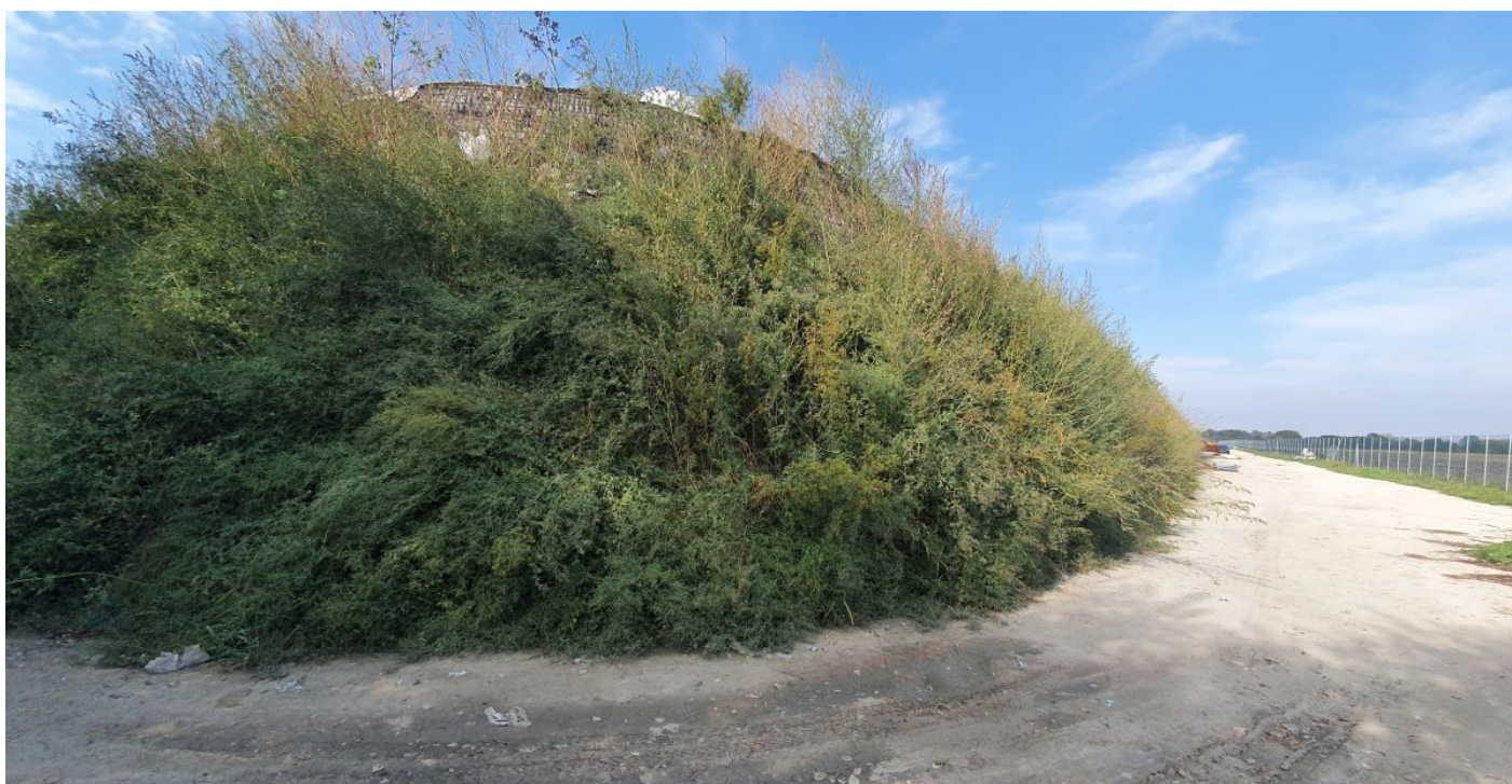
Rinverdimento terra armata
