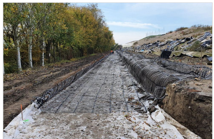
Stesa geogriglie PARADRAIN per terra armata bifacciale
