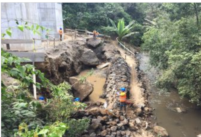
Durante a obra
