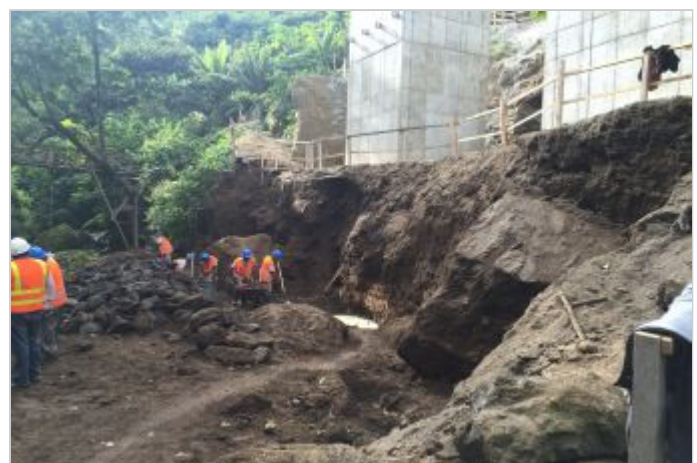
Durante a obra
