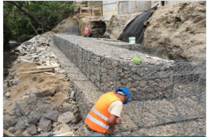
Durante a obra
