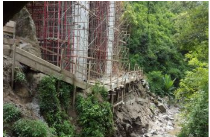
Antes da Obra
