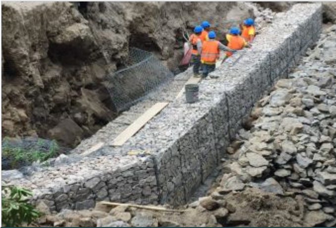
Durante a obra
