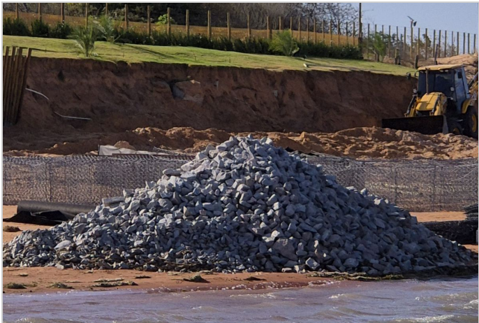
Durante a obra
