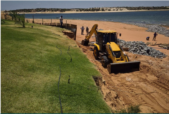
Durante a obra
