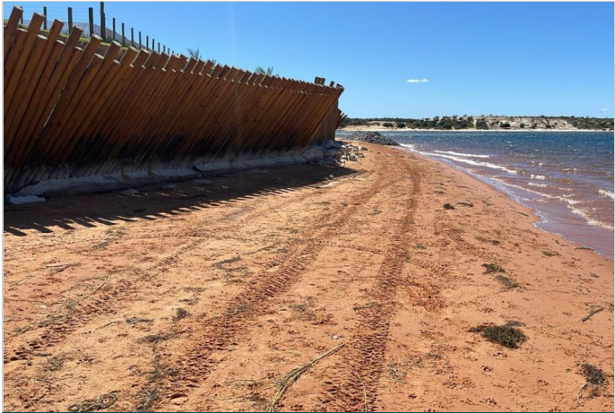
Antes da Obra
