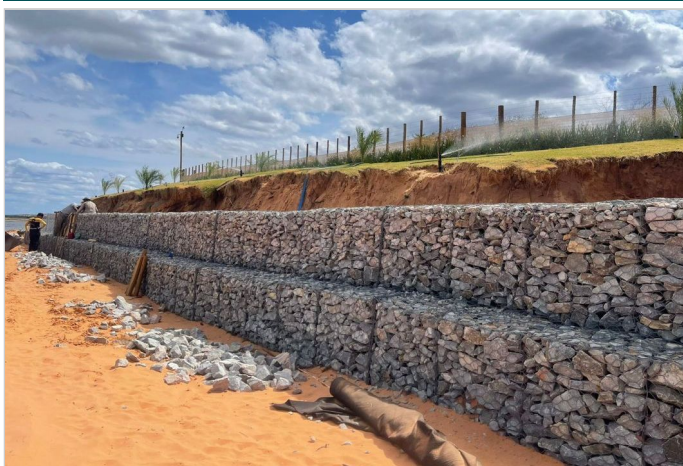
Durante a obra
