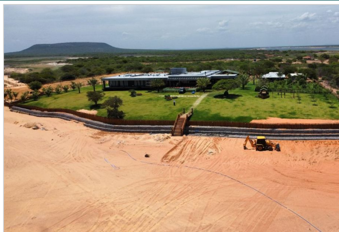
Durante a obra
