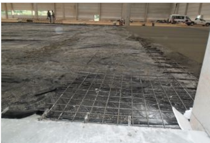
Durante la Obra
