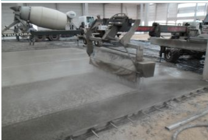
Durante la Obra
