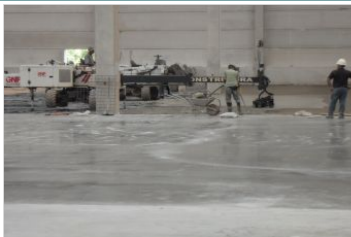
Durante la Obra
