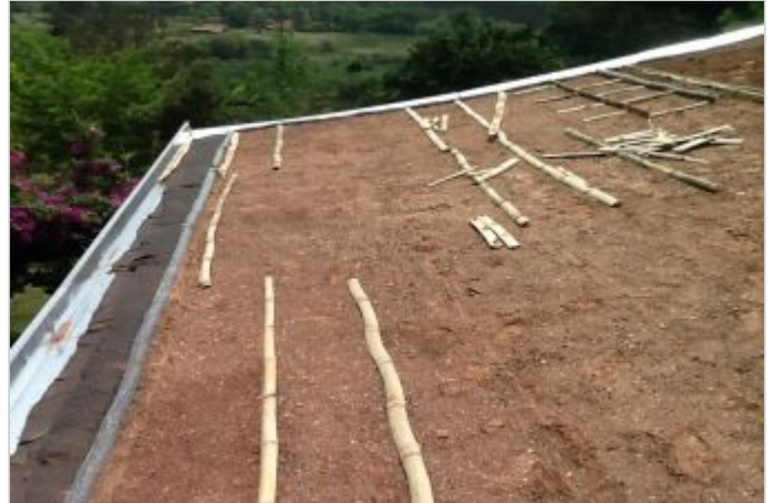
Durante la Obra
