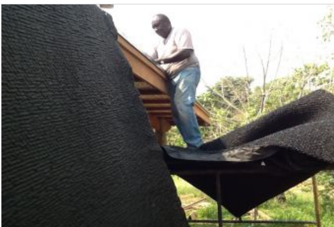
Durante la Obra
