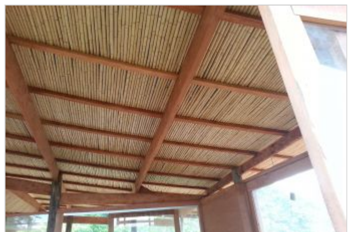
Durante la Obra
