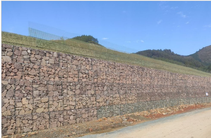
加筋格宾施工
