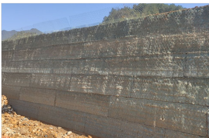
加筋格宾施工
