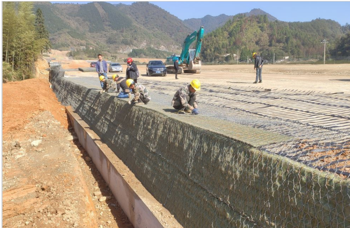
绿色加筋格宾施工
