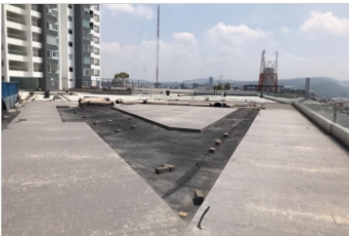
Durante a obra
