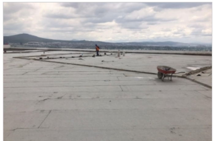
Durante a obra
