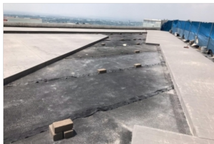
Durante a obra
