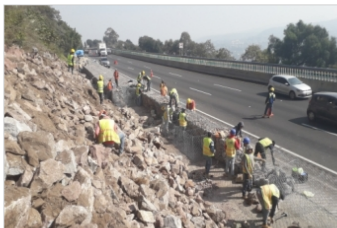
Durante la Obra
