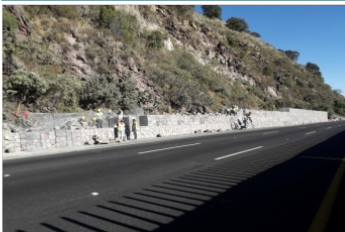
Durante la Obra
