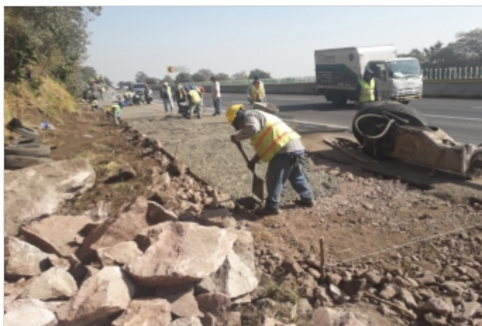
Durante la Obra
