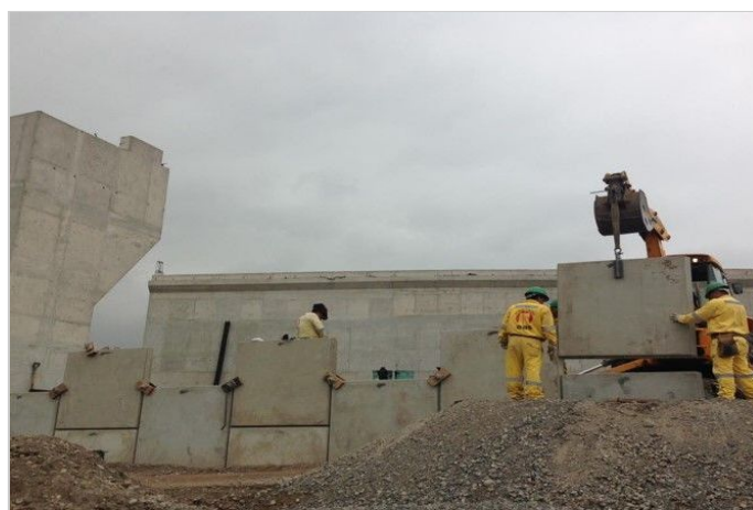
Durante la Obra
