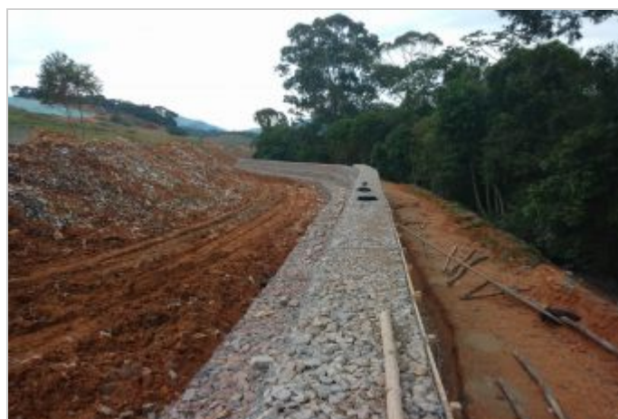
Durante a obra
