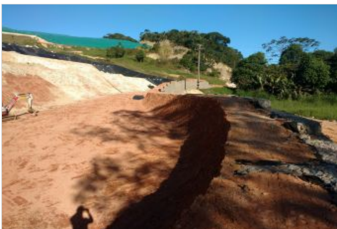
Durante a obra
