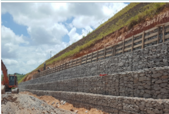
Durante a obra
