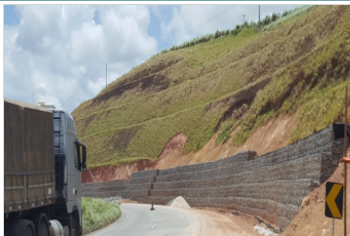
Durante a obra
