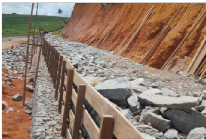
Durante a obra
