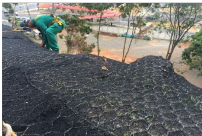
Durante a obra
