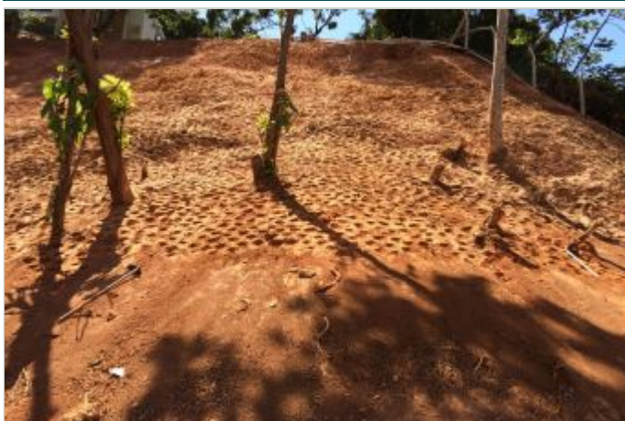
Durante a obra
