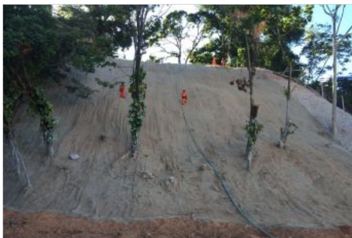
Durante a obra
