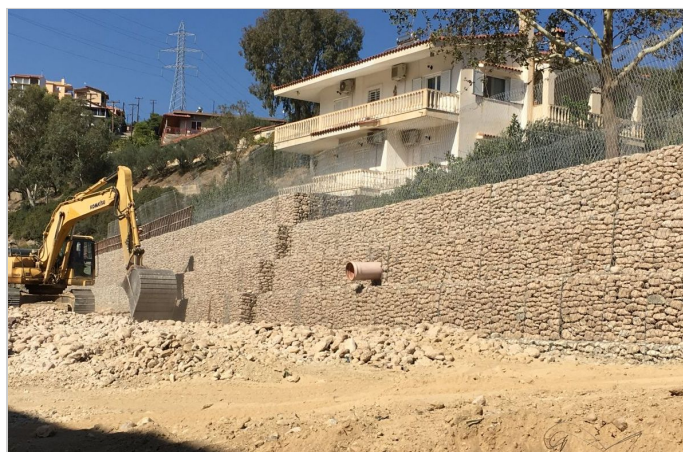
GALFAN ΠΡΟΚΑΤΑΣΚΕΥΑΣΜΕΝΑ ΣΥΡΜΑΤΟΚΙΒΩΤΙΑ ΣΤΗ ΦΑΣΗ ΤΗΣ ΚΑΤΑΣΚΕΥΗΣ
