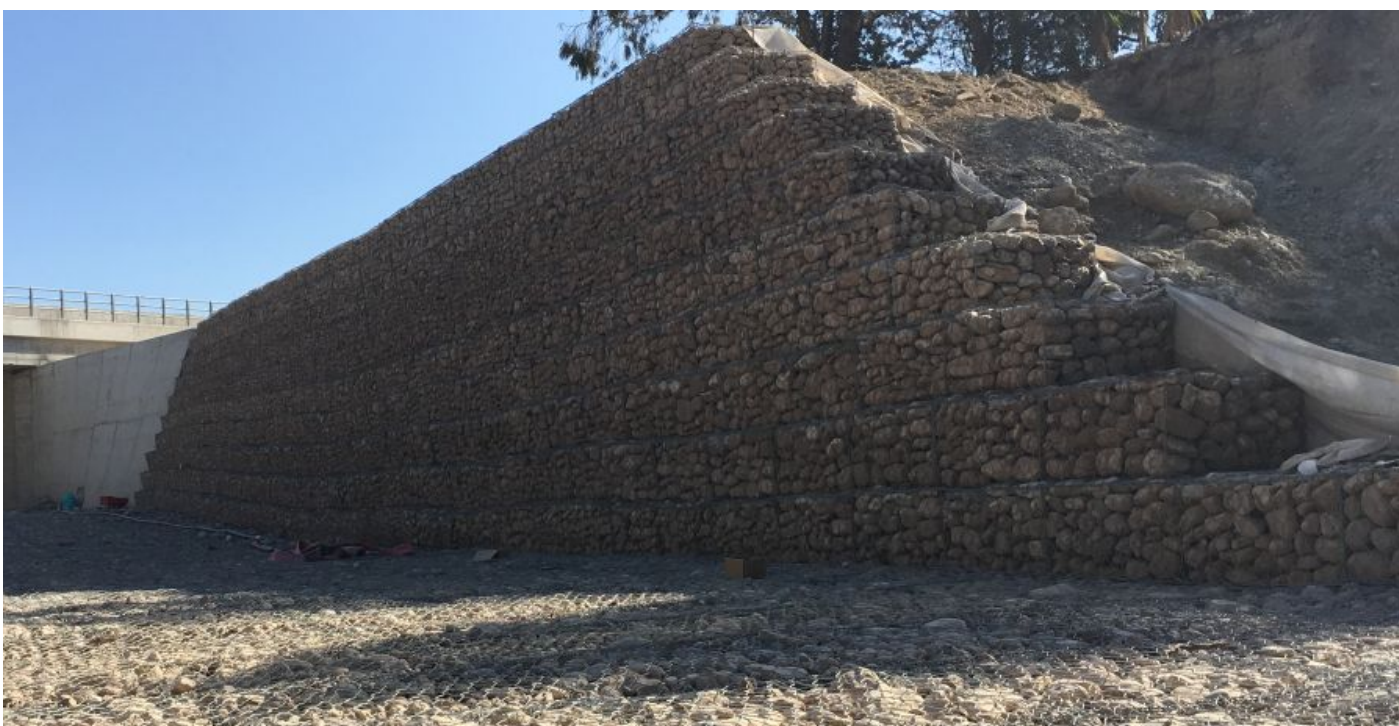
ΕΠΕΝΔΥΣΗ ΠΥΘΜΕΝΑ ΚΑΙ ΠΡΑΝΩΝ ΜΕ GALFAN ΣΥΡΜΑΤΟΚΙΒΩΤΙΑ
