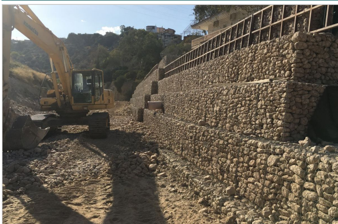
ΠΡΟΚΑΤΑΣΚΕΥΑΣΜΕΝΑ GL ΣΥΡΜΑΤΟΚΙΒΩΤΙΑ ΣΤΗ ΦΑΣΗ ΤΗΣ ΚΑΤΑΣΚΕΥΗΣ
