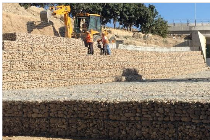
ΚΟΙΤΟΣΤΡΩΣΗ ΚΑΙ ΕΠΕΝΔΥΣΗ ΠΡΑΝΩΝ ΜΕ GALFAN ΣΥΡΜΑΤΟΚΙΒΩΤΙΑ
